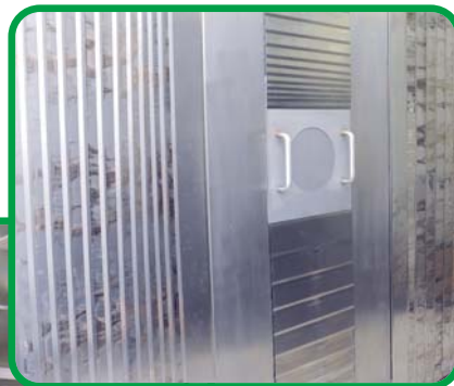
EITEC测试中心 / Testcenter
